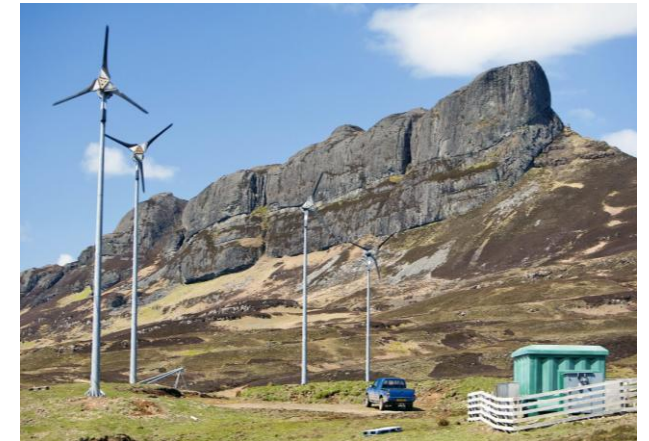
(Aerogeneradores en la isla de Eigg © BBC)
